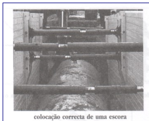
Figura 15 – Colocação correcta de uma escora.
