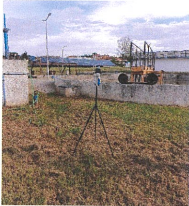
Figura 1. ETAR da Ribeira de Sintra – Tanque de Arejamento
