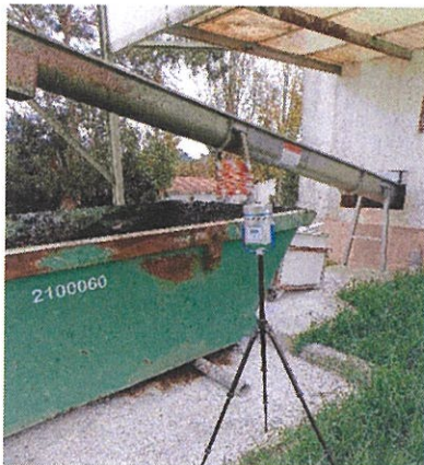
Figura 4. ETAR de Colares – Desidratação de Lamas
